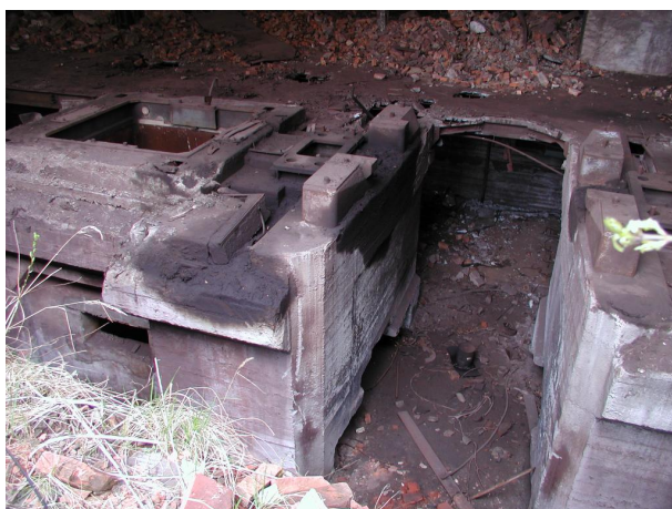
základy exhaustorů a odtah spalin
