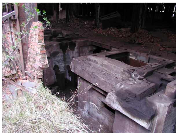
základy exhaustorů a odtah spalin
